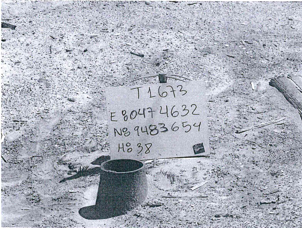
Fotografía N° 1. Pozo inactivo mal abandonado, sin cabezal, con tubo expuesto deteriorado y corroído de 6 pulgadas de diámetro.
