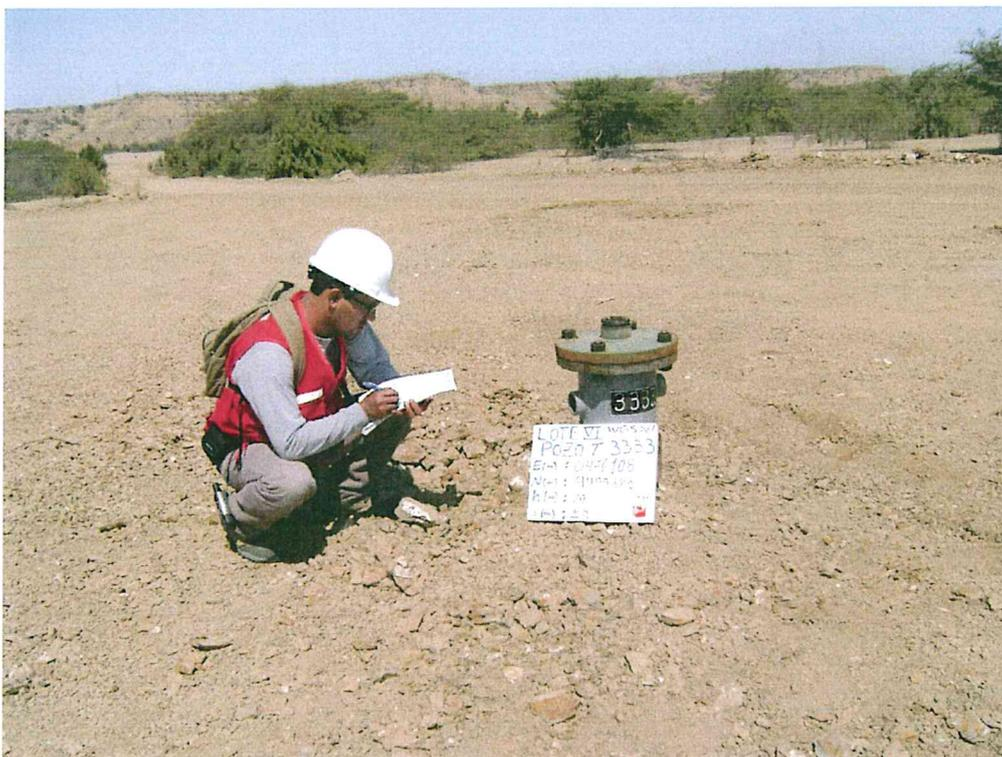
Fotografía N° 1. Se observa pozo mal abandonado al descubierto, con casing sin tapón y al aire libre.
