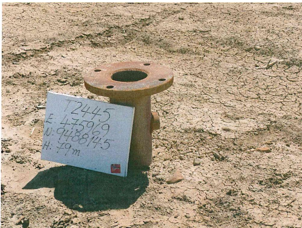
Fotografía N° 1. Pozo con código PERUPETRO T2445, con casing y brida, no sellado herméticamente.
