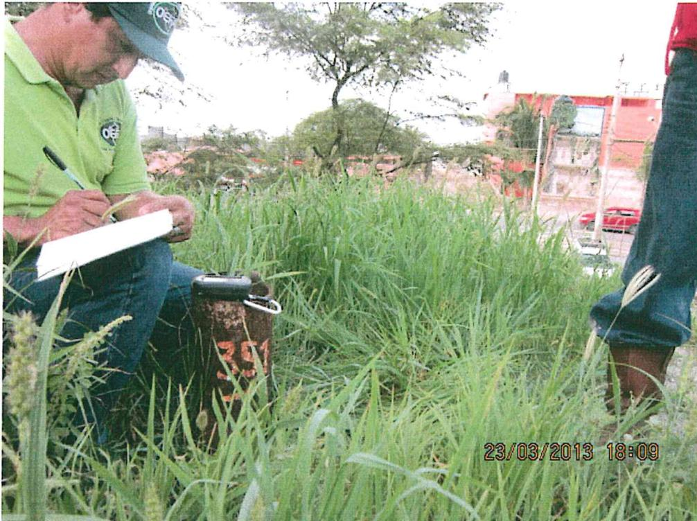
Fotografía N° 1. Pozo inactivo, sin cabezal, con casing de 0,20 m sobre el nivel del suelo, se encuentra cementado en su interior.
