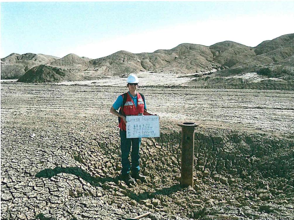
Fotografía N° 2. Pozo inactivo y abierto, ya que no presenta cabezal ni válvulas que lo mantengan hermético, sobresale una extensión de aproximadamente 1m.
