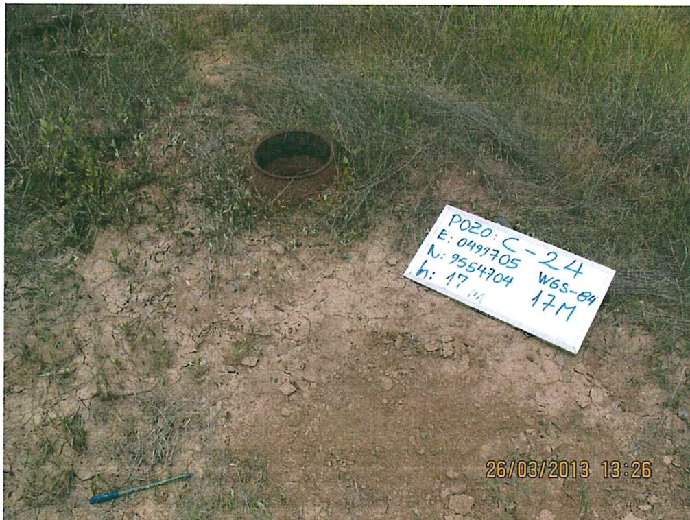
Fotografía N° 1. Pozo inactivo, se observa el casing a nivel de superficie que sobresale 5 cm, sin cabezal ni válvulas. No se observa afloramiento, ni se perciben olores característicos a hidrocarburos. No cuenta con señalización.
