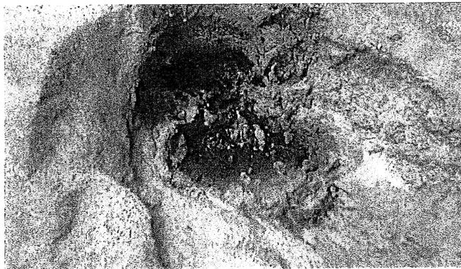
Fotografía N° 6. Se excavó en la coordenada de ubicación del pozo, aunque no se visualizó en terreno, se encontró que sigue emanando hidrocarburos acompañado de gases.
