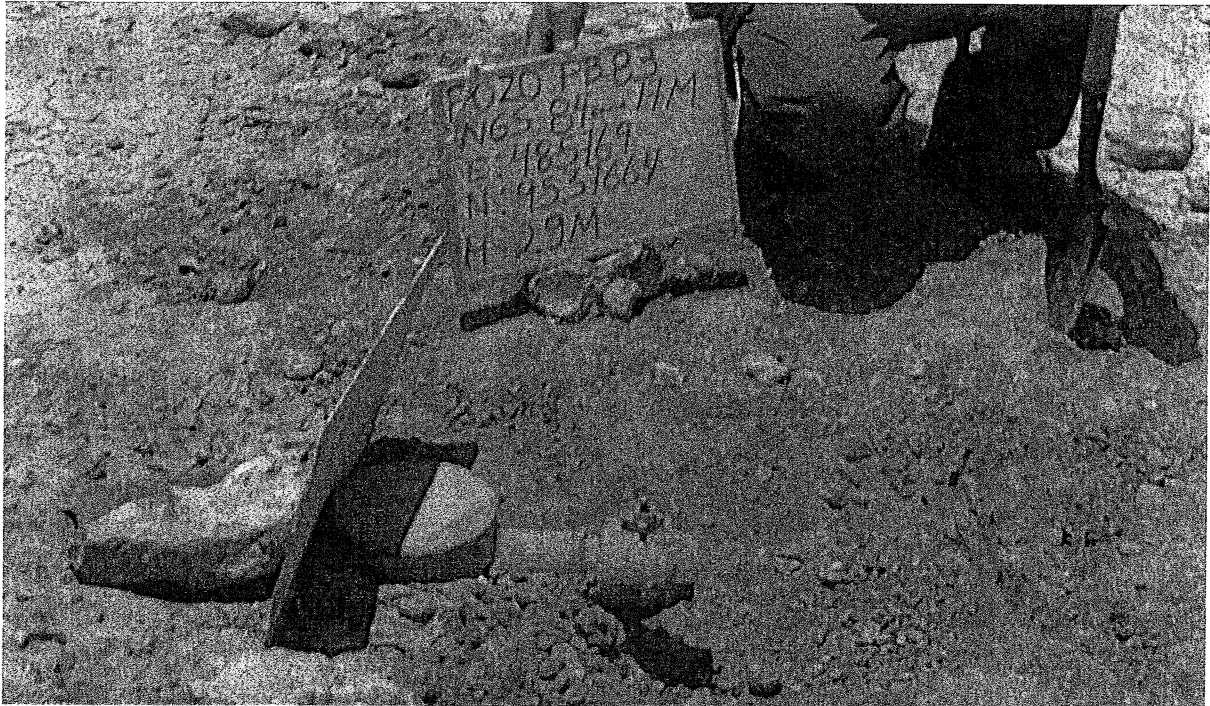
Fotografía N° 1. Se observó sobre el nivel de terreno un pozo inactivo, que presenta cople de casing de 7" colocado por operador actual PETROBRAS, para contención de posibles emanación de fluidos.
