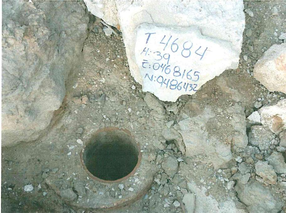
Fotografía N° 1. Pozo inactivo mal abandonado con código PERUPETRO T4684, sin cabezal, con casing y tubo interior a nivel del suelo.
