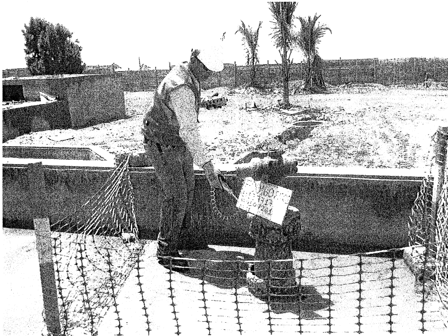
Fotografía N° 3. Monitoreo de emisiones gaseosas del pozo.
