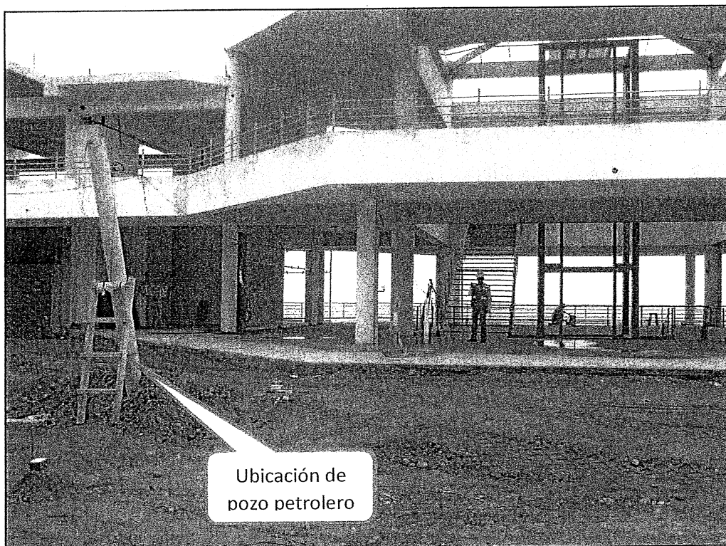
Fotografía N° 3. Medición radial desde 8 m de distancia hacia el pozo (25.FEB.14).
