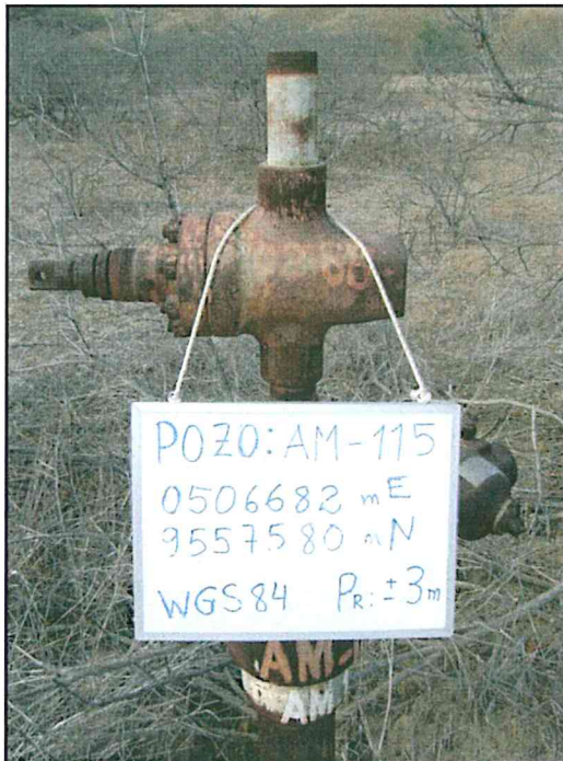
Fotografía N° 1. Pozo inactivo de 1,3 m sobre el nivel de la superficie del suelo, con válvulas y brida, sin plataforma.
