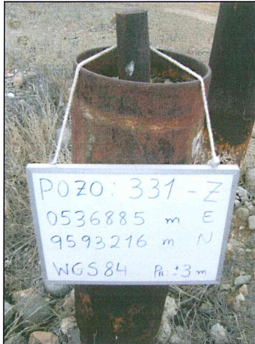
Fotografía N° 1. Pozo mal abandonado con casing de 1 m sobre el nivel del terreno.
