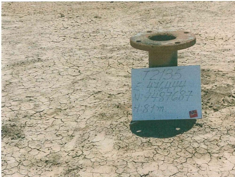
Fotografía N° 1. Pozo inactivo mal abandonado con código PERUPETRO T2135, presenta extensión de tubo con brida, no está sellado herméticamente.
