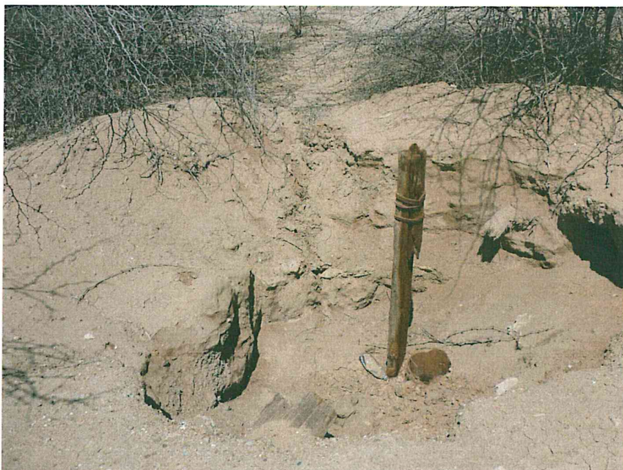
Fotografía N° 1. Pozo inactivo mal abandonado, sin cabezal, con casing de 10 pulgadas de diámetro dentro de un hoyo de aproximadamente 1,4 m de profundidad.
