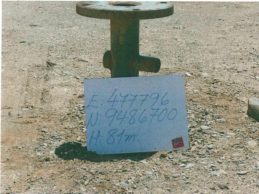
Fotografía N° 1. Pozo mal abandonado, sin cabezal, con extensión de tubo y brida que sobresale 0,58 m sobre el nivel del suelo.
