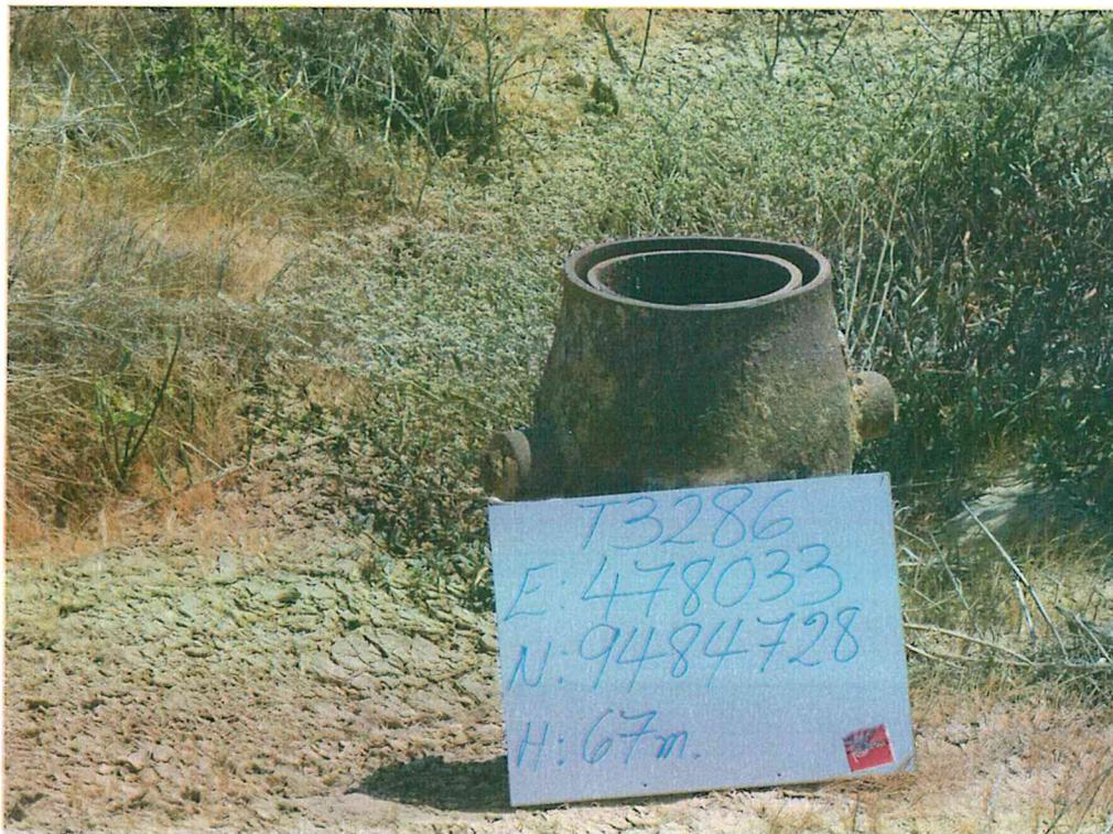
Fotografía N° 1. Pozo inactivo, presenta casing (tubería de revestimiento) y tubo interior de 10 y 8 pulgadas de diámetro respectivamente.
