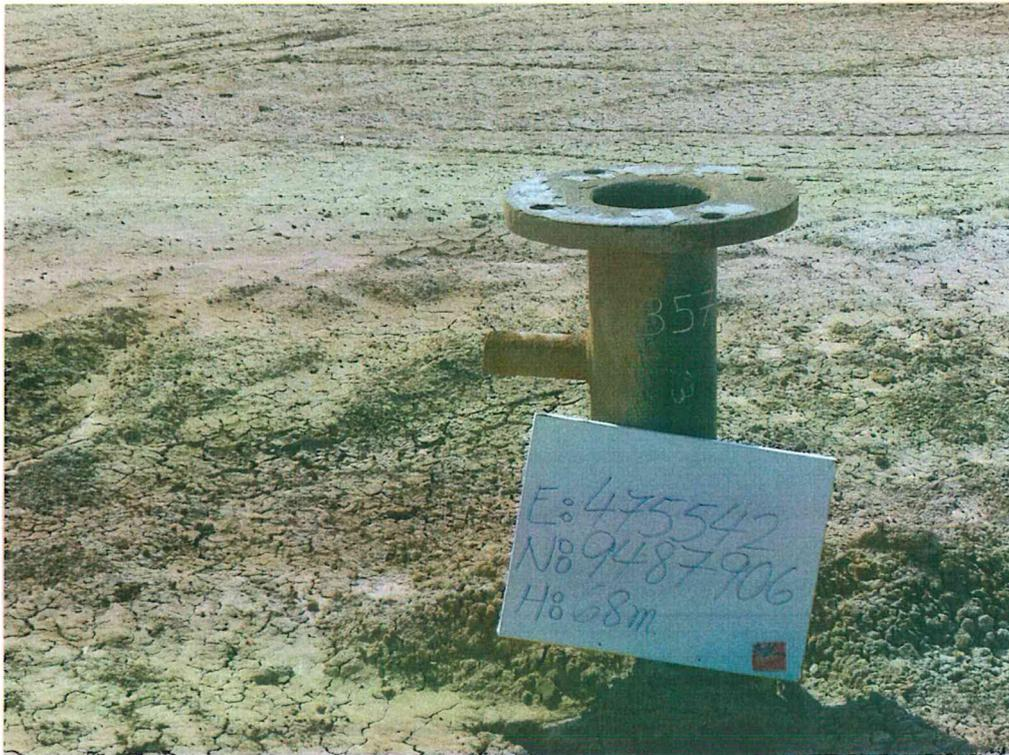
Fotografía N° 1. Pozo inactivo, con extensión de tubo y brida expuesta, sin válvulas ni tapones que aseguren su hermetismo.
