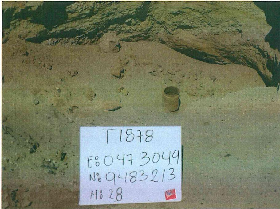
Fotografía N° 1. Pozo inactivo, con casing (tubería de revestimiento) corroído que presenta acumulación de tierra en su interior, dentro de un hoyo de aproximadamente 1,75 m de profundidad.
