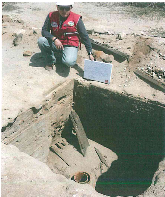
Fotografía N° 1. Pozo inactivo mal abandonado, con código PERUPETRO T3358, sin cabezal y dentro de una cantina deteriorada de 1,56 m aproximadamente de profundidad.
