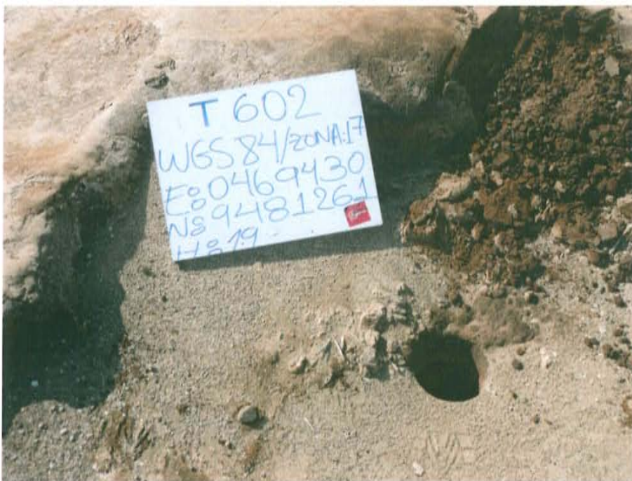
Fotografía N° 1. Pozo inactivo mal abandonado, sin cabezal, con casing superficial a nivel del suelo.
