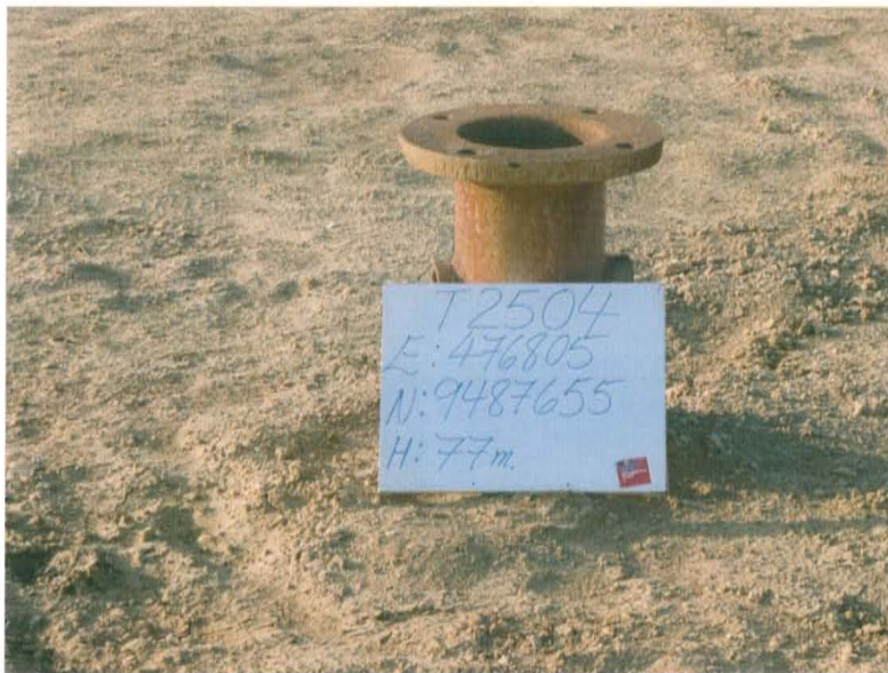
Fotografía N° 1. Pozo mal abandonado con código PERUPETRO T2504, se observa extensión de tubo con brida corroído, no se encuentra sellado herméticamente.
