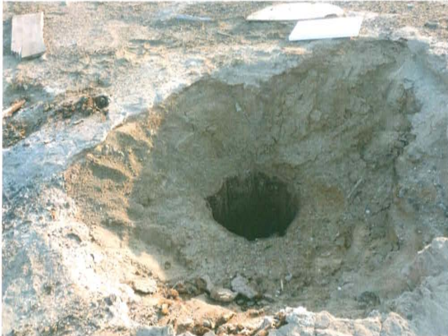
Fotografía N° 2. El pozo se encuentra dentro de un hoyo de aproximadamente 0,6 m de profundidad.
