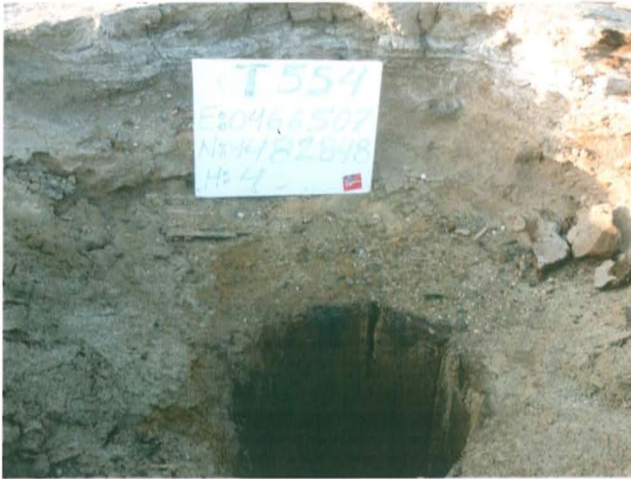
Fotografía N° 1. Pozo inactivo mal abandonado, sin cabezal, presenta un revestimiento de madera.
