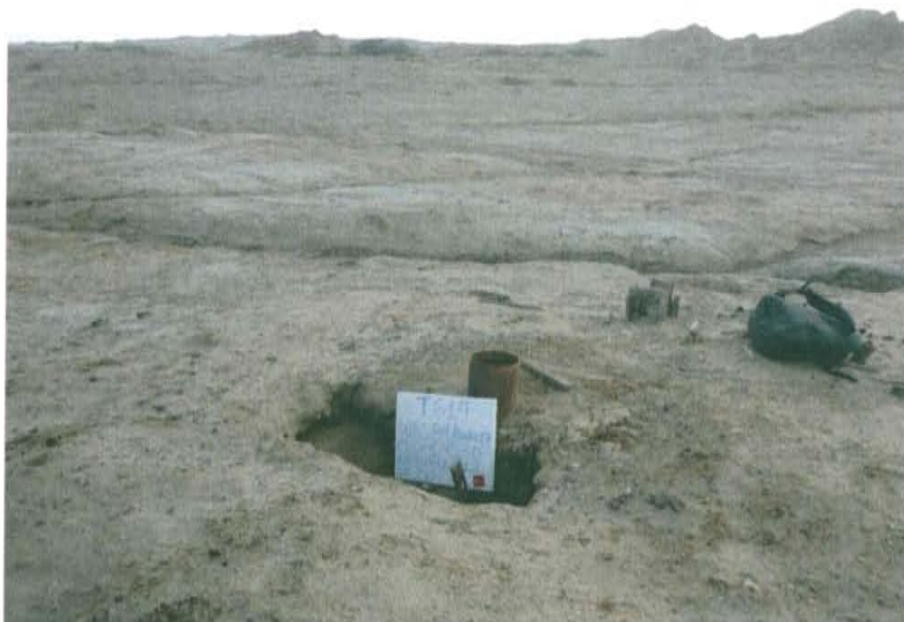
Fotografía N° 2. Pozo mal abandonado, se encuentra dentro de un hoyo, en terreno no habilitado.
