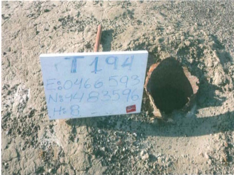
Fotografía N° 1. Pozo inactivo, sin cabezal, con casing corroído y deteriorado, no sellado herméticamente.
