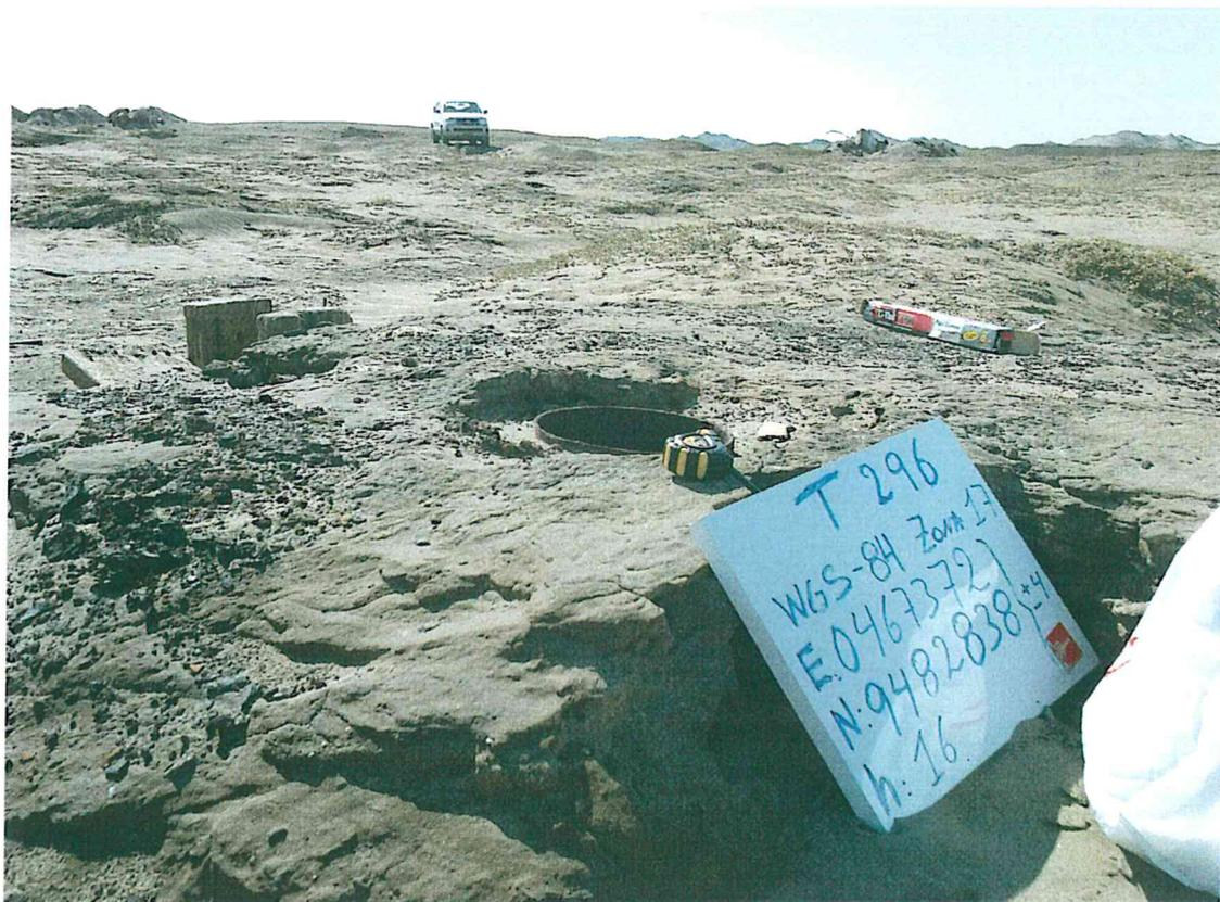
Fotografía N° 2. Vista lateral del casing al ras de la superficie del suelo, no cuenta con cabezal ni válvulas, se considera abierto.
