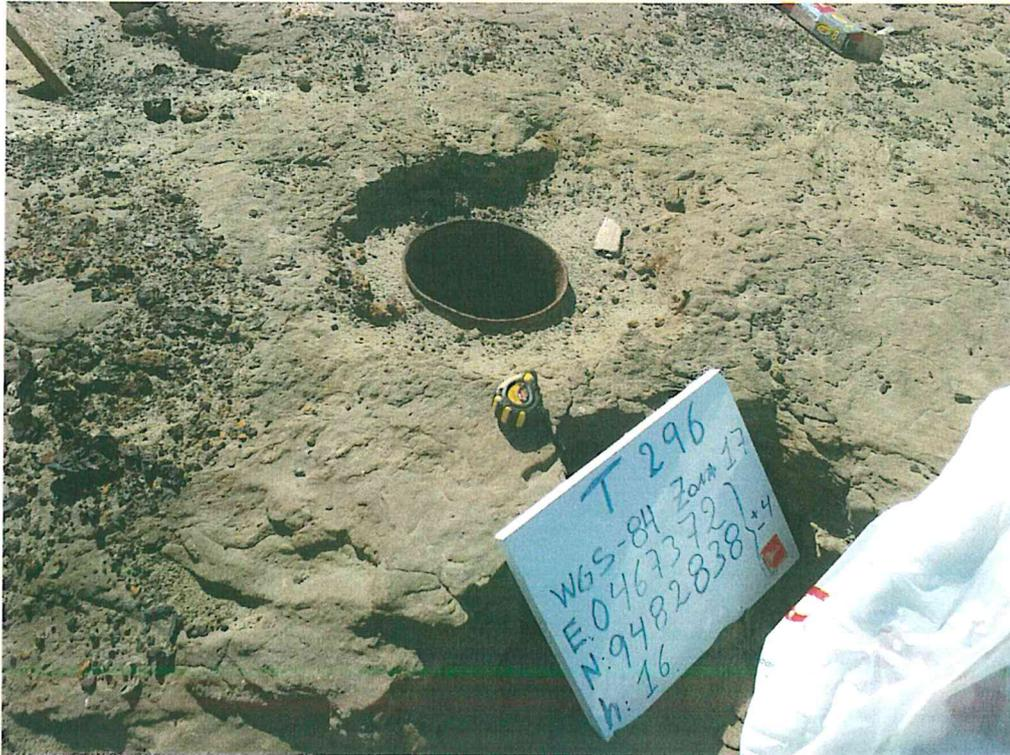
Fotografía N° 3. Vista del casing a ras del suelo, sin cabezal ni válvulas, se considera abierto.
