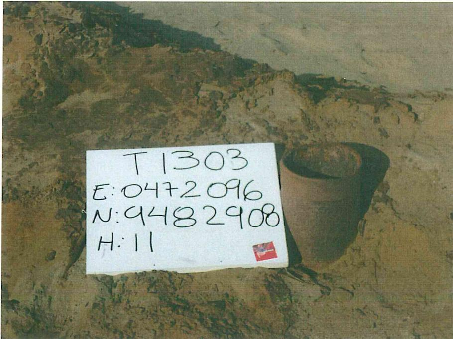
Fotografía N° 1. Pozo inactivo mal abandonado, sin cabezal, con casing corroído que sobresale 0,20 m sobre el nivel del suelo, con acumulación de tierra en su interior.
