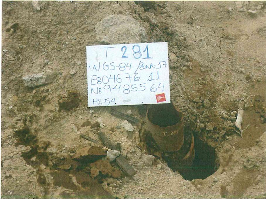
Fotografía N° 1. Pozo inactivo mal abandonado, sin cabezal, con casing y tubo interior corroído.
