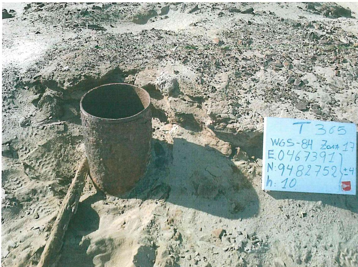
Fotografía N° 2. Vista del casing del pozo T\_365, sobresaliendo sobre la superficie del suelo. Se observa suelo impregnado con hidrocarburos en los alrededores.
