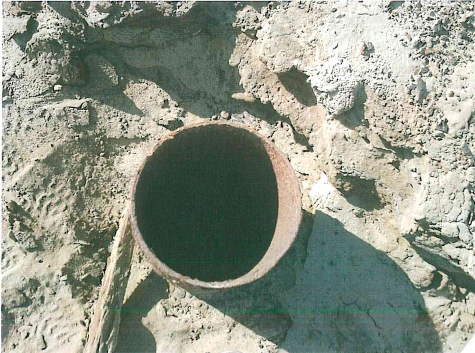
Fotografía N° 3. El Casing no cuenta con cabezal ni válvula por lo que se considera abierto.
