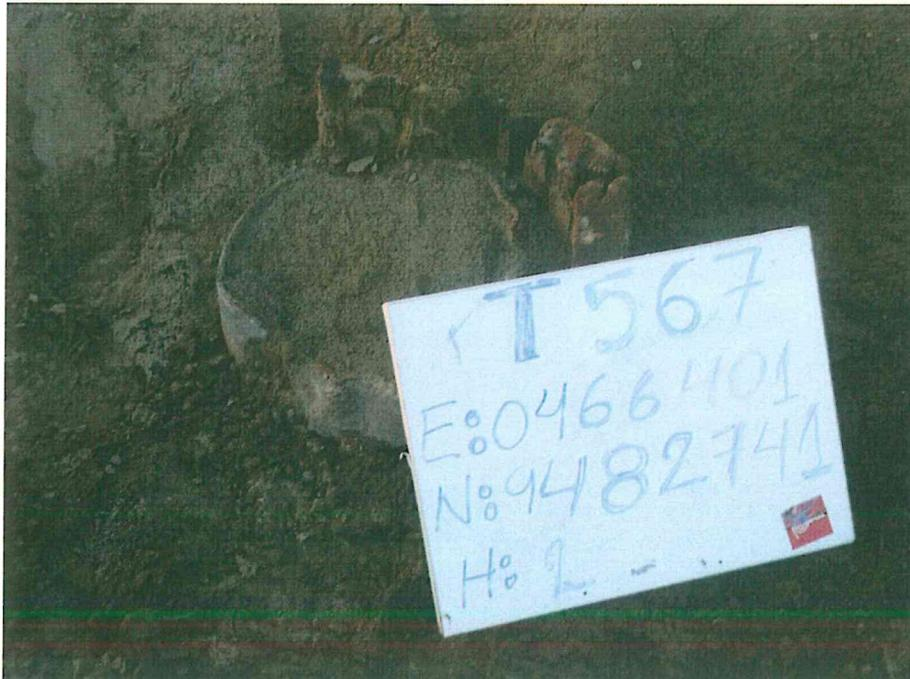
Fotografía N° 1. Pozo inactivo, se observa casing a nivel del suelo con acumulación de tierra en su interior.
