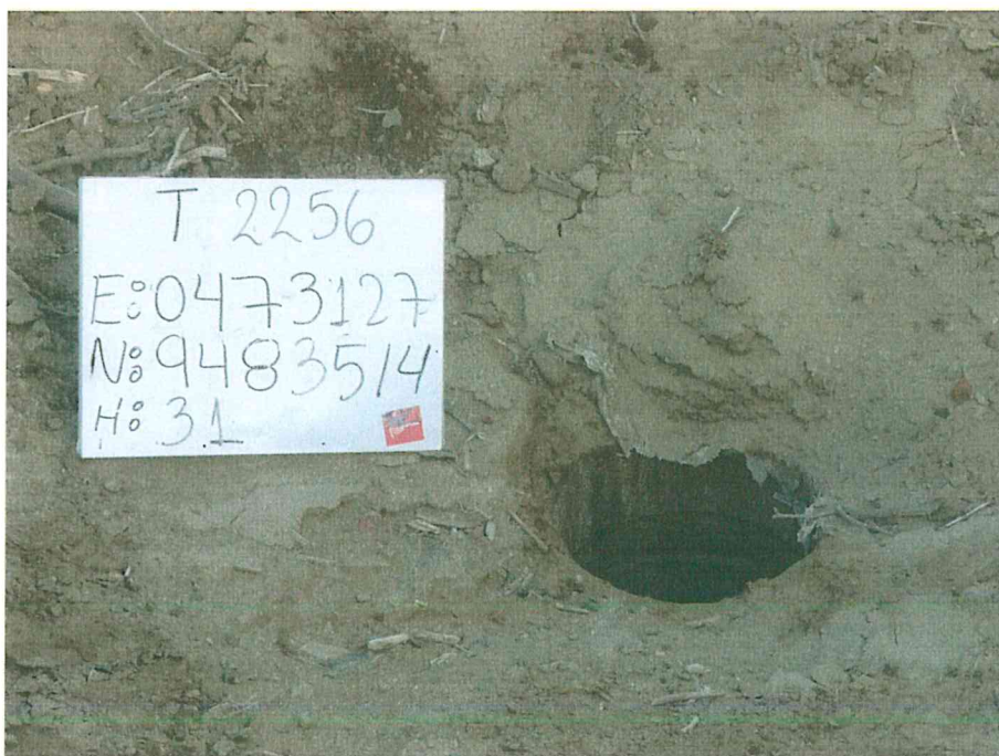
Fotografía N° 1. Pozo inactivo mal abandonado, sin cabezal, con casing a nivel del suelo de 12 pulgadas de diámetro.
