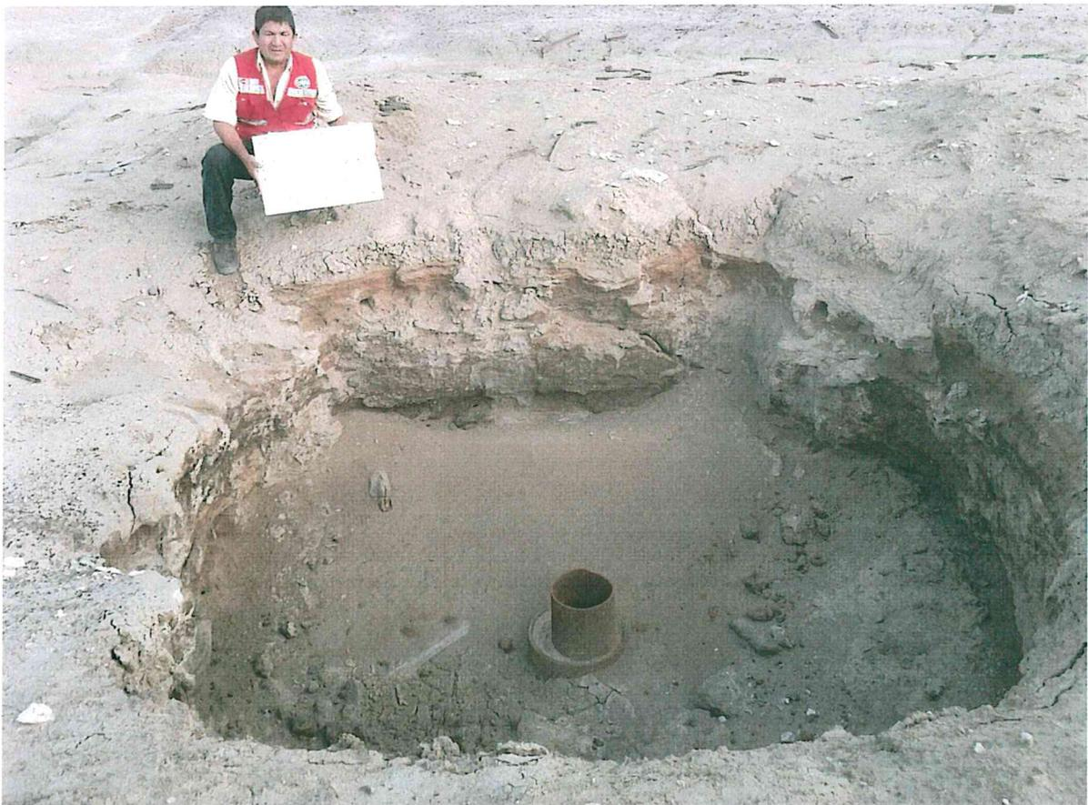
Fotografía N° 2. Vista del casing del pozo ubicado dentro de excavación, no posee cabezal ni válvula por lo que se considera abierto
