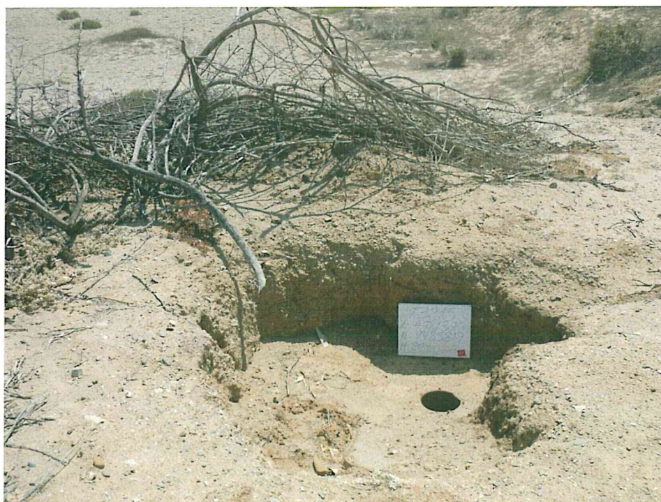
Fotografía N° 2. Pozo ubicado dentro de un hoyo de aproximadamente 0,58 m de profundidad.
