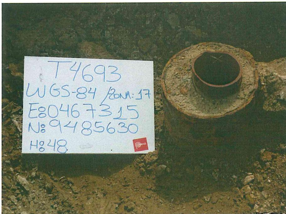
Fotografía N° 2. El pozo presenta casing superficial cementado y tubo interior corroído.
