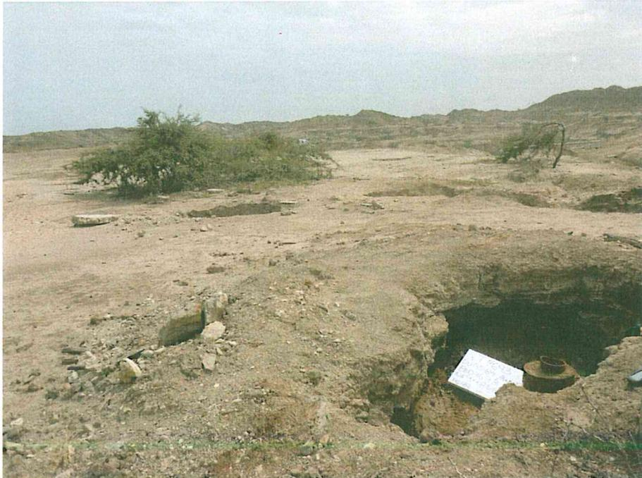
Fotografía N° 1. Pozo inactivo mal abandonado dentro de un hoyo de aproximadamente 0,80 m de profundidad.
