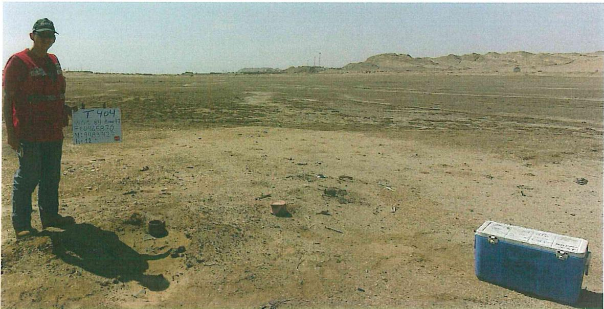
Fotografía N° 1. Vista de pozo inactivo T\_404 que no presenta terraplén ni acceso. Se observó casing a nivel de superficie, sin válvulas que aseguren su hermetismo.
