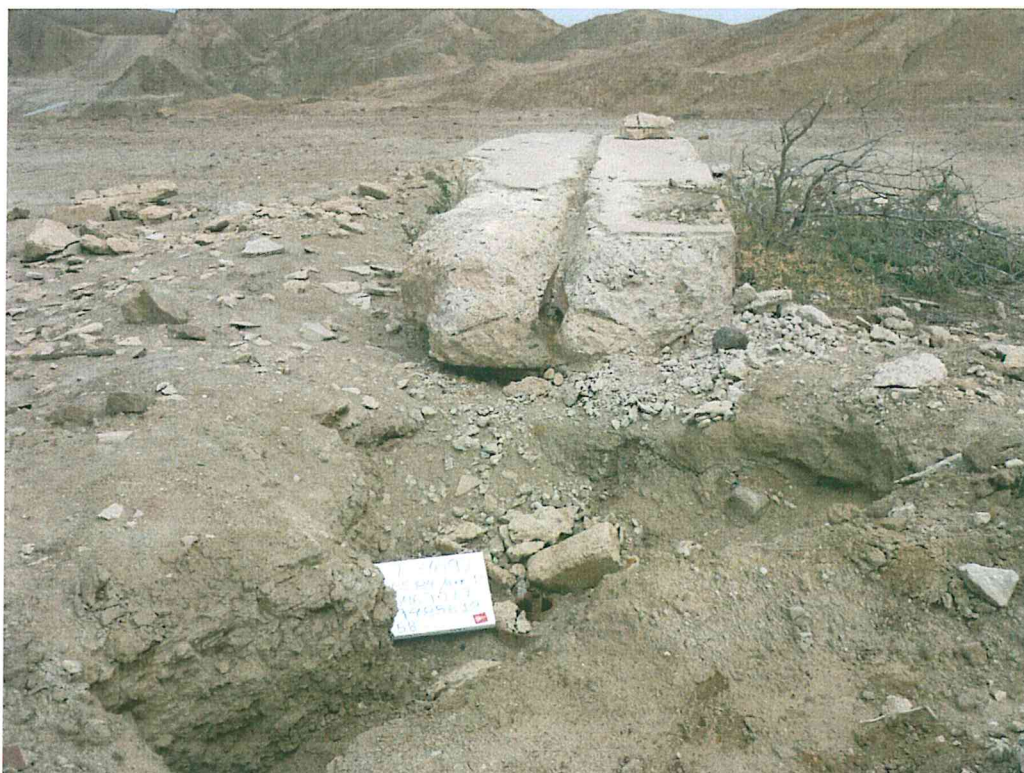
Fotografía N° 4. Presencia de bloque de concreto (viga monolítica) aproximadamente a 2 m de la ubicación del pozo.
