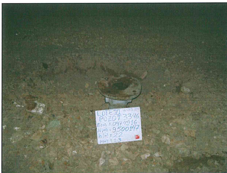
Fotografía N° 2. Pozo mal abandonado observándose suelo impregnado con hidrocarburo.
