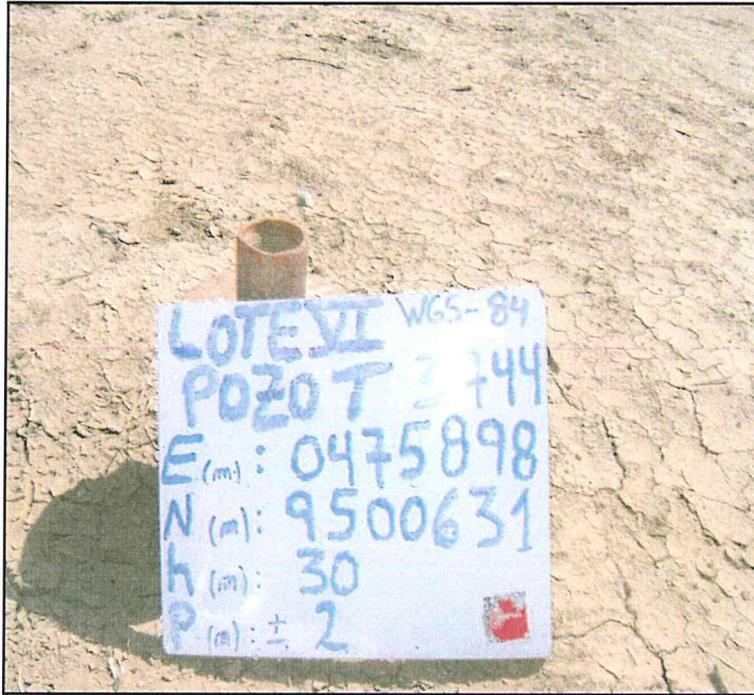
Fotografía N° 1. Pozo mal abandonado con casing expuesto 0,25 m sobre el nivel del suelo.
