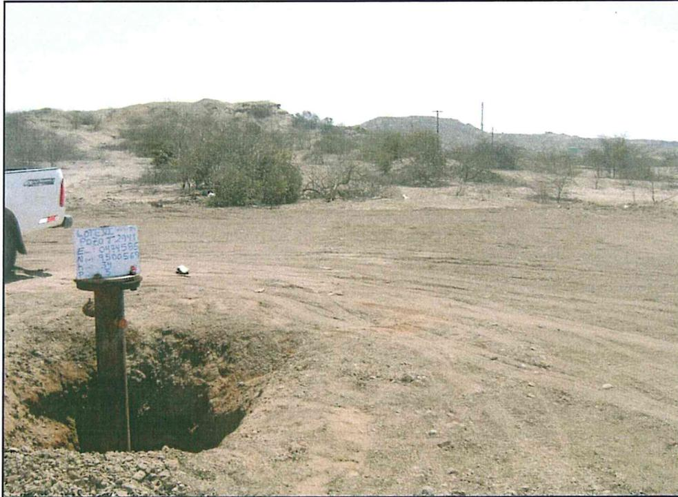
Fotografía N° 1. Se observa pozo mal abandonado con casing y expuesto al aire libre.
