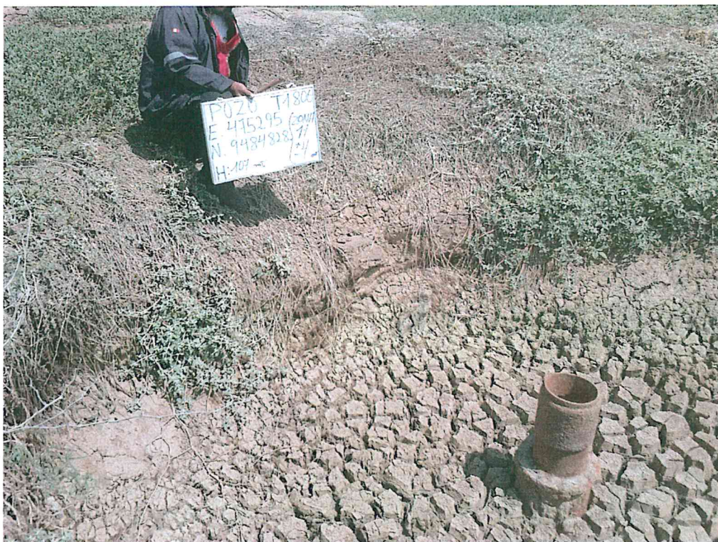
Fotografía N° 1. Se observa el pozo inactivo de código T1806, se observa el casing cortado y sin válvulas, por lo que se considera abierto al ambiente.
