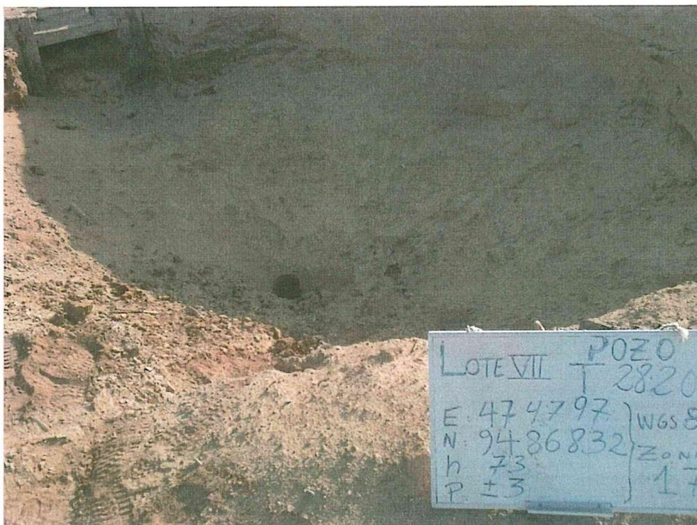
Fotografía N° 1. Se ubicó el pozo en una excavación, se observó el casing cortado, sin ningún elemento de cierre, por lo que se encuentra abierto.
