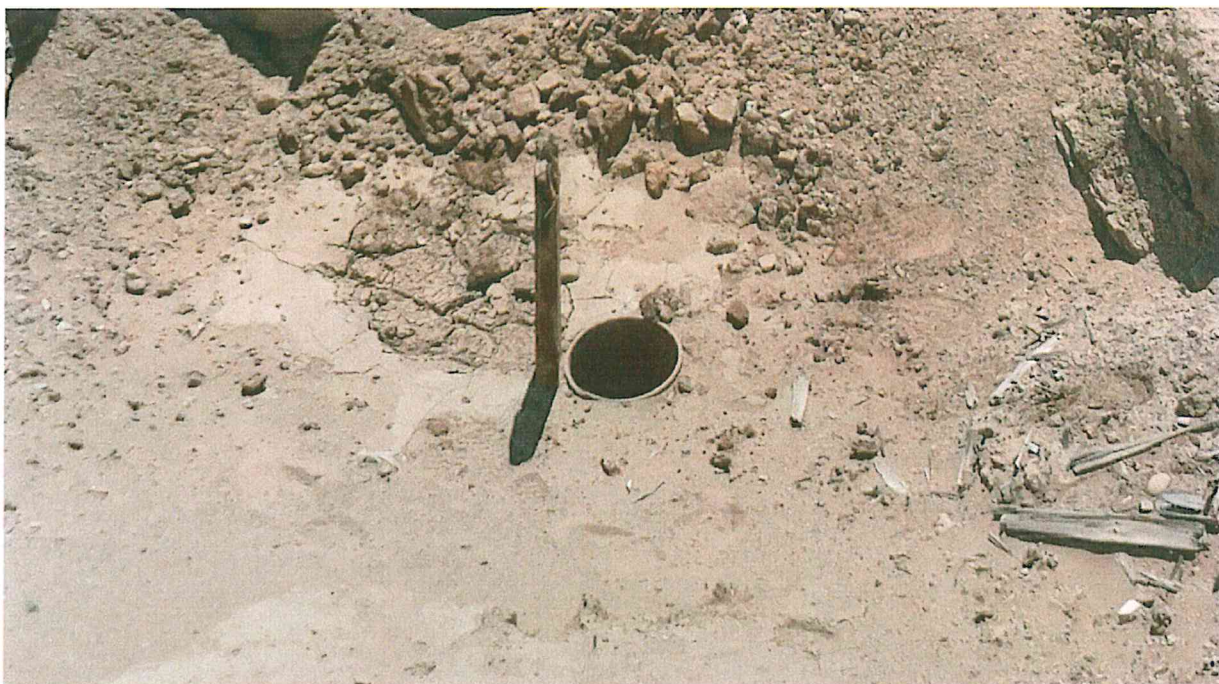
Fotografía N° 1. Se ubicó el pozo T2827, se observa el casing cortado dentro de una excavación
