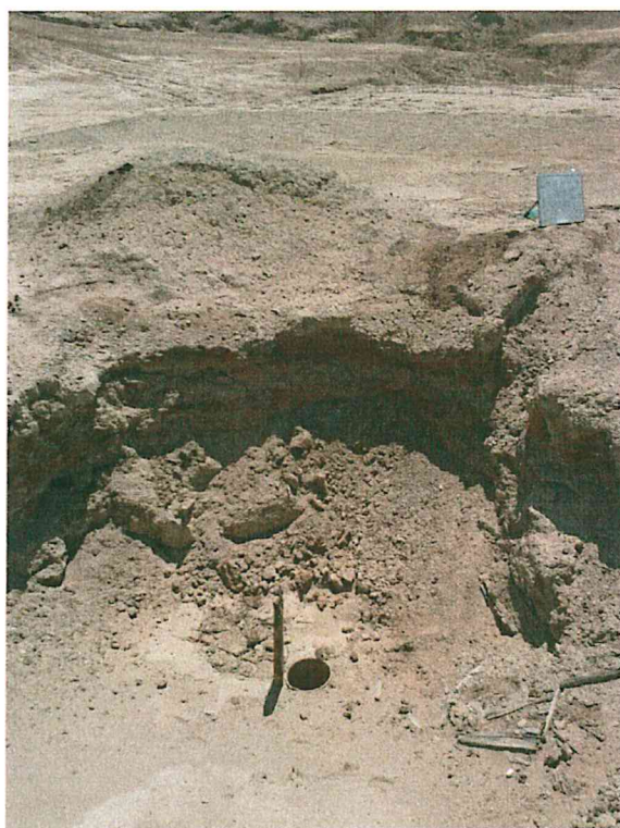
Fotografía N° 2. Se observó la excavación donde se ubicó el casing del pozo.
