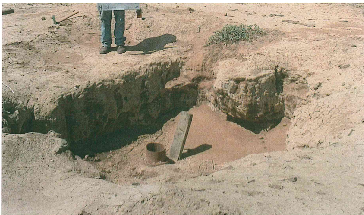
Fotografía N° 1. Se ubicó al pozo T1674, se observó un pozo inactivo, cuyo casing está cortado, por lo que se considera abierto.
