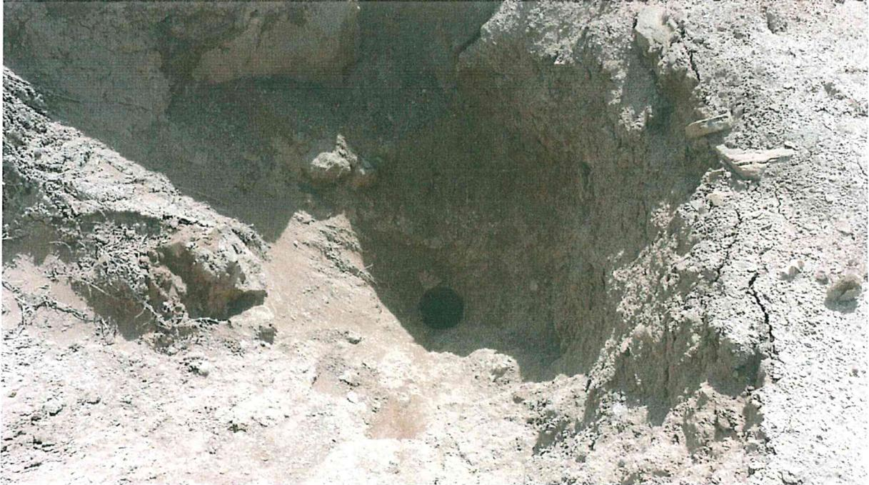
Fotografía N° 1. Se ubicó el pozo en superficie, se observó el casing a ras del nivel de una excavación, presenta el casing cortado, por lo tanto abierto.
