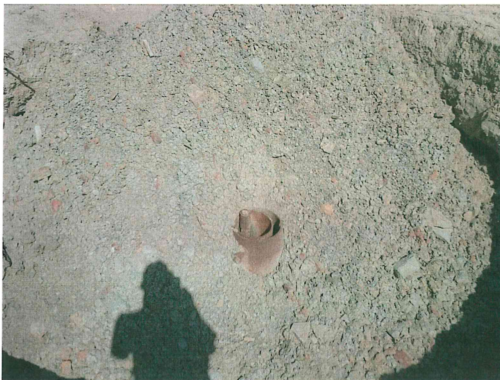
Fotografía N° 1. Se ubicó al pozo T2345, se observó el casing cortado, se considera pozo abierto.
