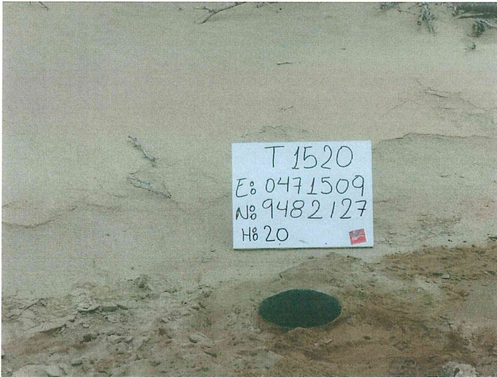
Fotografía N° 1. Pozo T1520 inactivo con código PERUPETRO, no posee cabezal, el casing se encuentra a nivel del suelo.
