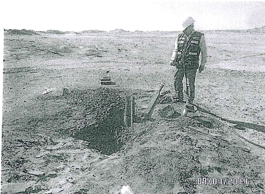
Fotografía N° 2. Mediciones en el F00103-VA01, se realizó en un recorrido en el área circundante alrededor del Pozo T_634 en un radio de 1 m, con una duración de 10 minutos.
