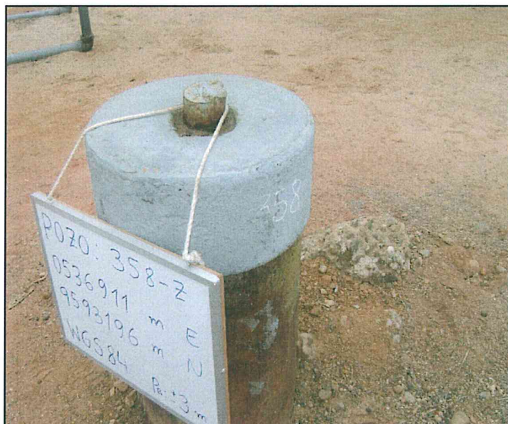
Fotografía N° 1. Pozo inactivo, se observa casing que sobresale 0,5 m sobre el nivel de la superficie del suelo.
