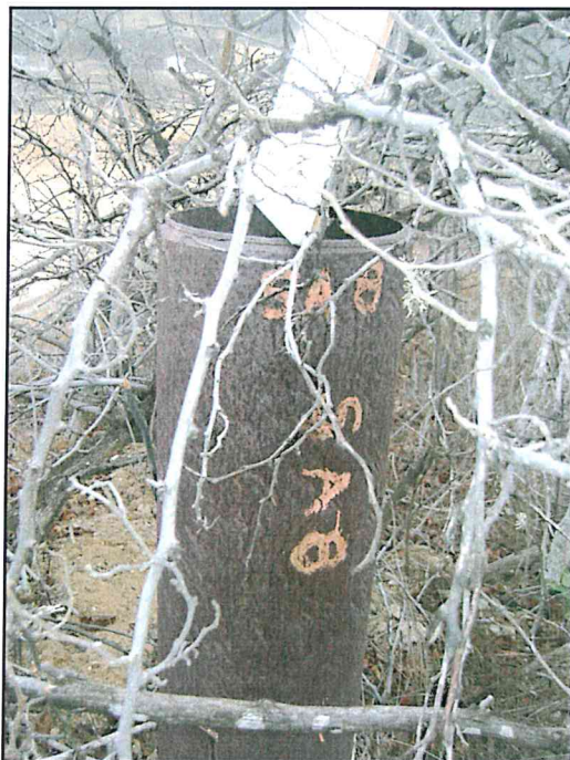
Fotografía N° 2. Pozo con casing que sobresale 0,5 m sobre la superficie del suelo.
