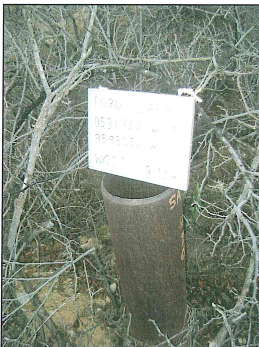
Fotografía N° 1. Pozo inactivo y mal abandonado, dentro de matorral seco.
