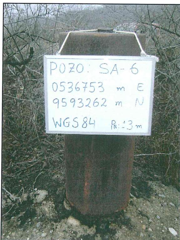
Fotografía N° 1. Vista frontal del pozo mal abandonado con cemento en su interior.
